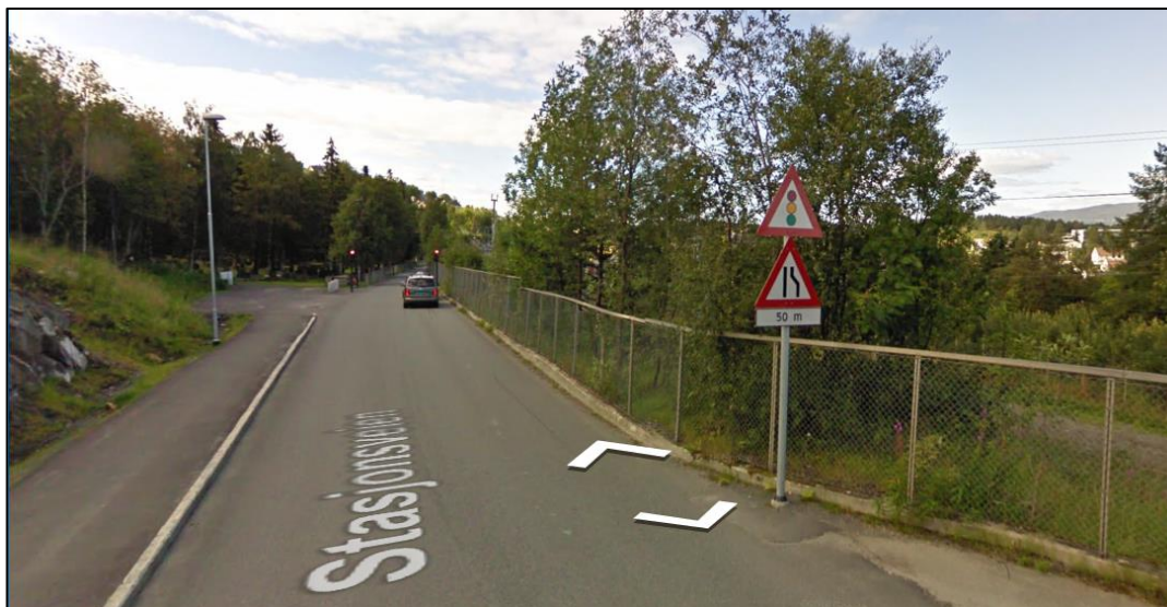
Figur 7 Skyttelsignalanlegget i Stasjonsveien sett mot vest (google streetview fra august 2010).
