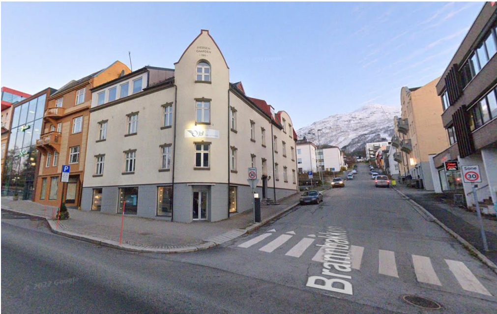
Figur 100: Kongens gate 56 (Iversengården – oppført 1911) midt i bildet. Bygget er i jugendstil med buede arker som ikke er typisk for gjenreisningsarkitekturen. Dronningens gate 59 (Thorsengården – oppført 1913) til høyre i bildet. Foto: Google Street View oktober 2022.
