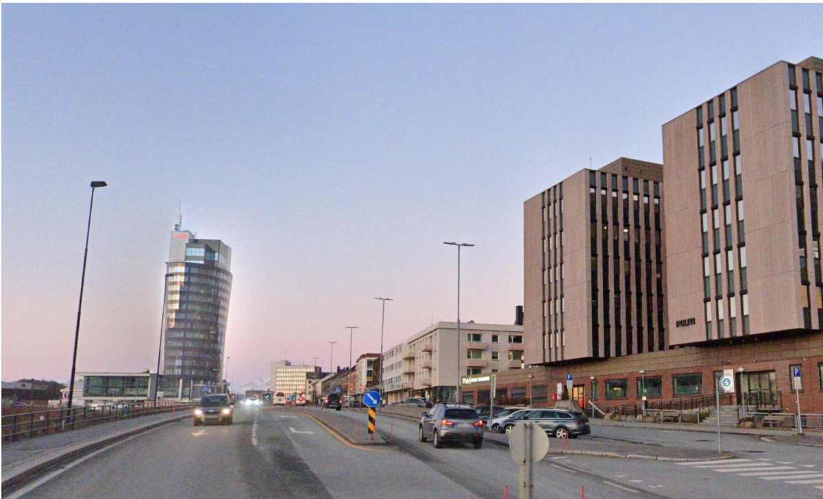
Figur 19: Bilde er tatt fra sørlige del av Kongensgate mot nord. Til høyre i bildet kan man se «Post- og politibyggget» som er 6-7 etasjer, høyde på bygge fra gateplan er ca. 26.5 meter. Scandic hotell på 18 etasjer og en høyde fra gateplan på ca. 55 meter ligger til venstre i bildet. Rett frem kan man se Narvik rådhus på 8-9 etasjer og en høyde fra gateplan på ca. 32 meter.
