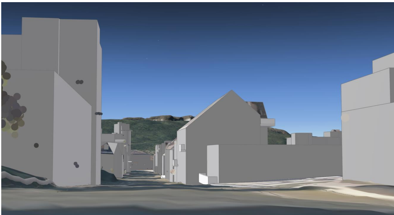
Figur 51: Dagens situasjon illustrert fra krysset Tøttaveien x Dronningens gate i retning sørvest langsmed Dronningens gate. Til venstre i bilde ligger Narvik Videregående skole, studiested Oscarsborg og til høyre er Quality Grand hotell. Midt i bildet kan man se Scandic hotell. Kilde: Nordlandatlas.
