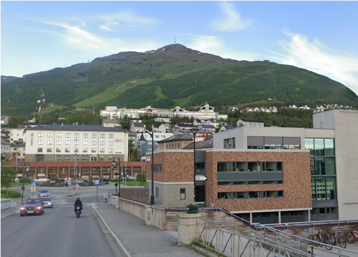
Figur 23: Bilde tatt fra Brugata mot sørøst. I bildet kan man se noe av bebyggelsen rundt Narvik torg. Linken 1007 moh. På toppen av Fagernesfjellet, Alpinanlegget med gondolbane som går opp til Fjellheisrestauranten ca. 650 moh., samt bebyggelsen til UIT Narvik.
