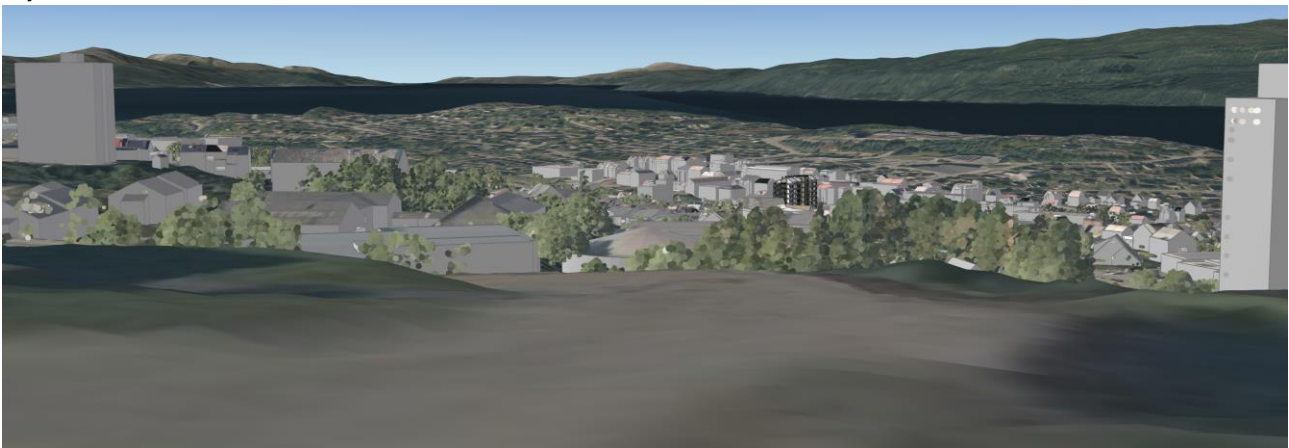
Figur 73: Framtidig situasjon illustrert fra krysset Mårveien x Reinveien, retning vest. Kilde: Partgroup/Sweco.
