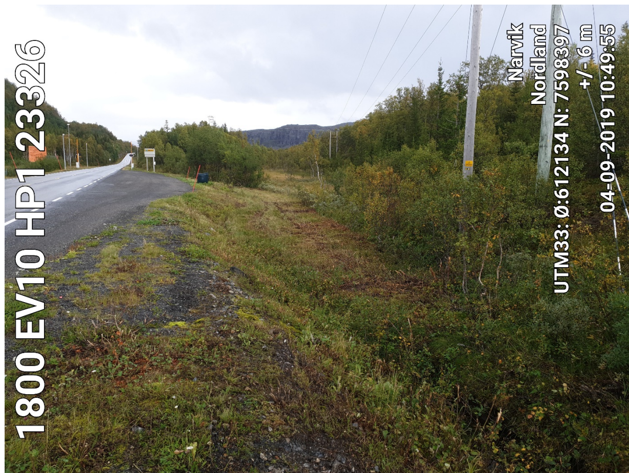
Figur 3 – Utfyllinger høyre side ved Trollvann brøytestasjon
