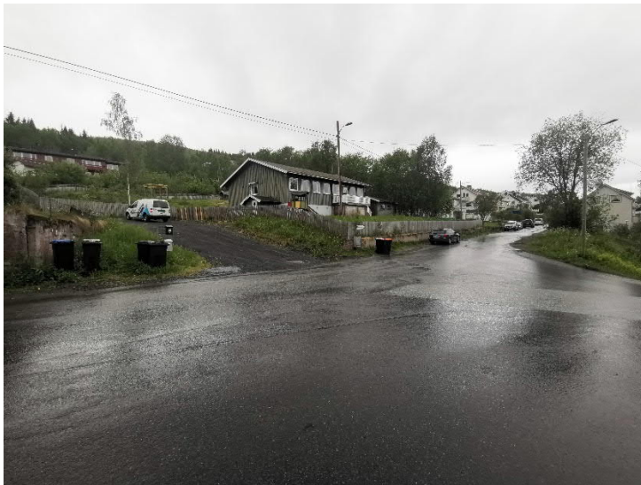
Krysset i Svartdalsbakken mot skogveien.
