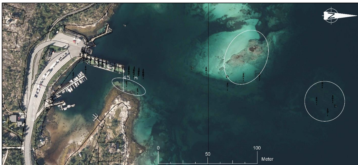
Figur 1: Oversiktsfoto over Skarberget fergekai. Hvit ring ved fergeleiet markerer den delen av odden som skal sprenges, mens de to andre ringene markerer skjærene som skal jevnes ut.
