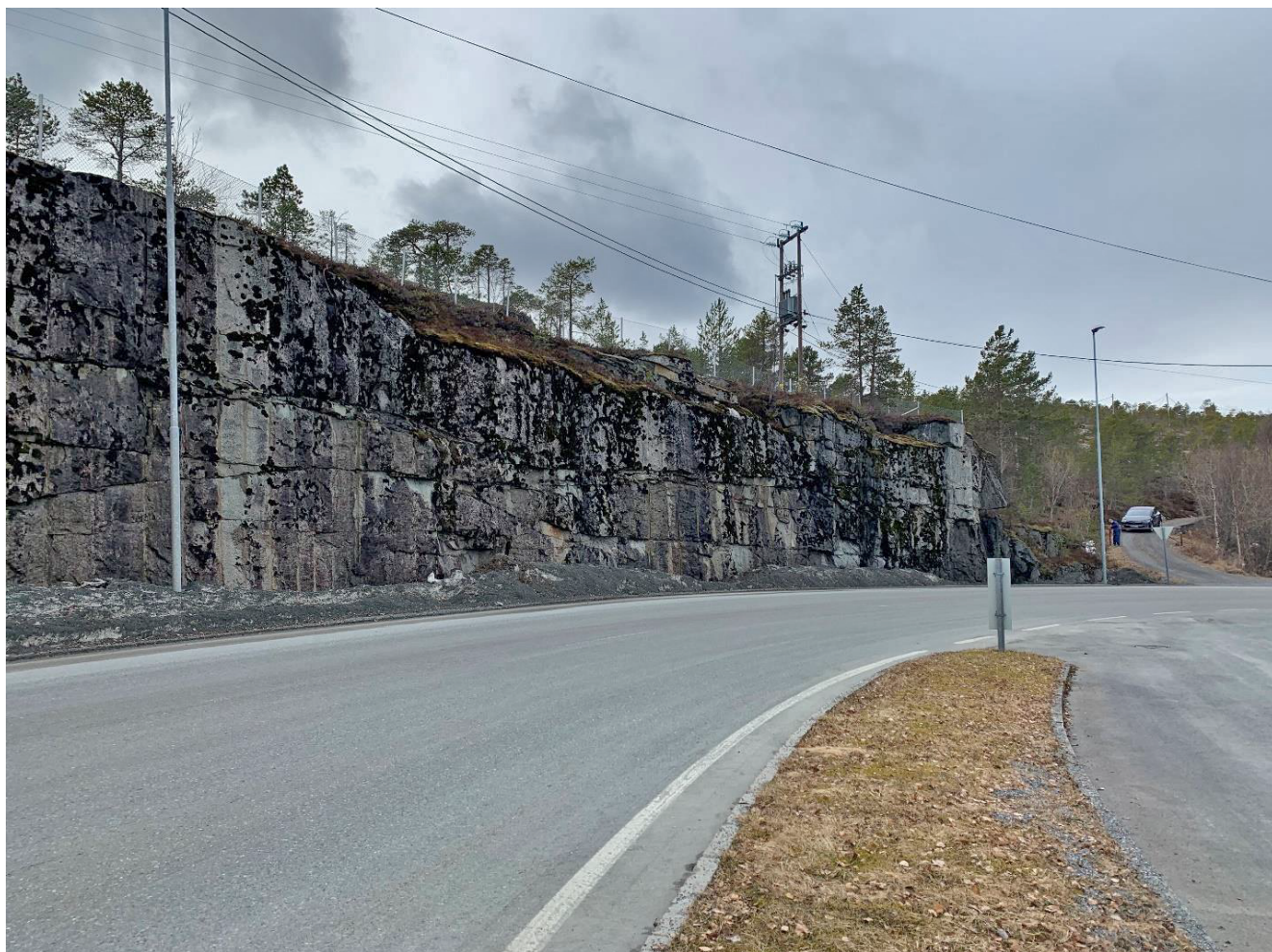
Foto 7: Vest for fergekaia er det i dag en eksisterende bergsjæring (høyde ca. 6 m)
