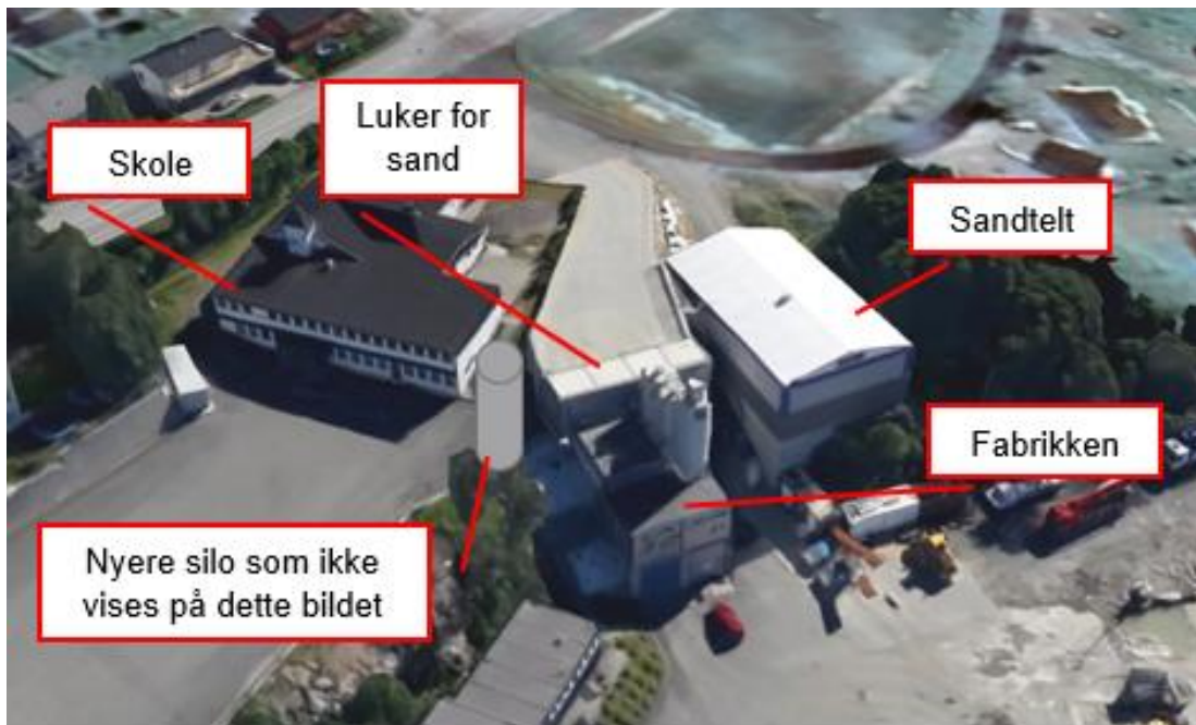
Figur 3: Oversiktsbilde over skole og betongfabrikk. Kilde: googlemaps
