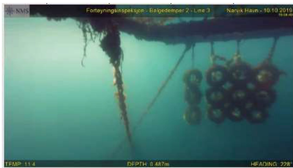
Figur 4 Underside av bølgedemper. Bildekk henger ned fra flyterørene for å øke dempende effekt. Foto: Narvik Maritime Service AS.
