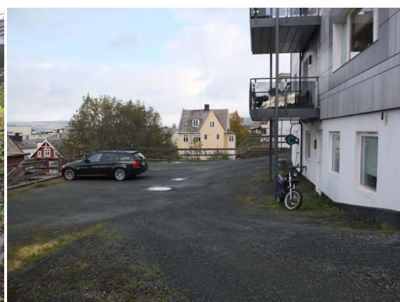
Figur 13. Gårdsplass til TH gt. 43, sett mot NØ. Foto Gisle Jakhelln september 2018.
