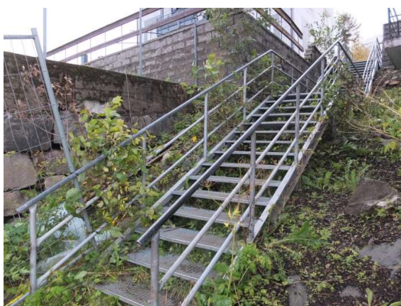
Figur 12. Trapp opp til Tore Hunds gate mellom TH gt. 41 og 43. Foto Gisle Jakhelln september 2018.
