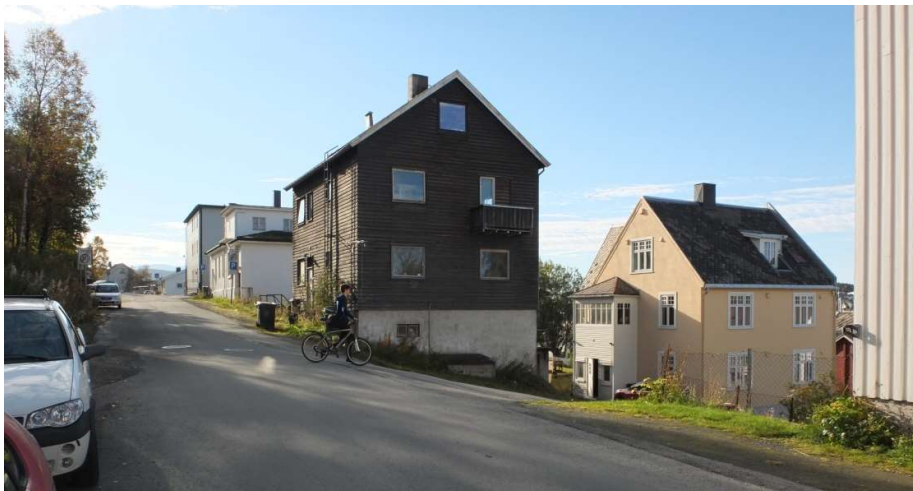
Figur 7. Planområdet sett fra øst langs Tore Hund's gate. Brannbakken ned til høyre. Foto Gisle Jakhelln september 2016.
