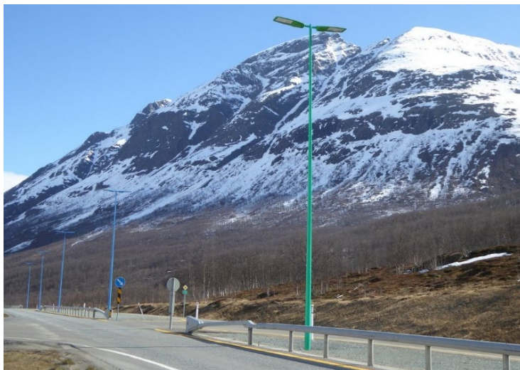
Figur 11 Eksempel på bruk av fargete master, fra Lavangsdalen i Tromsø (Foto: Erik Haagensen, Statens vegvesen)
