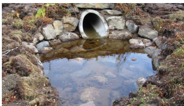
Figur 12 Steinsetting omkring stikkrenne (Foto: Elisabet Kongsbakk, Statens vegvesen)
