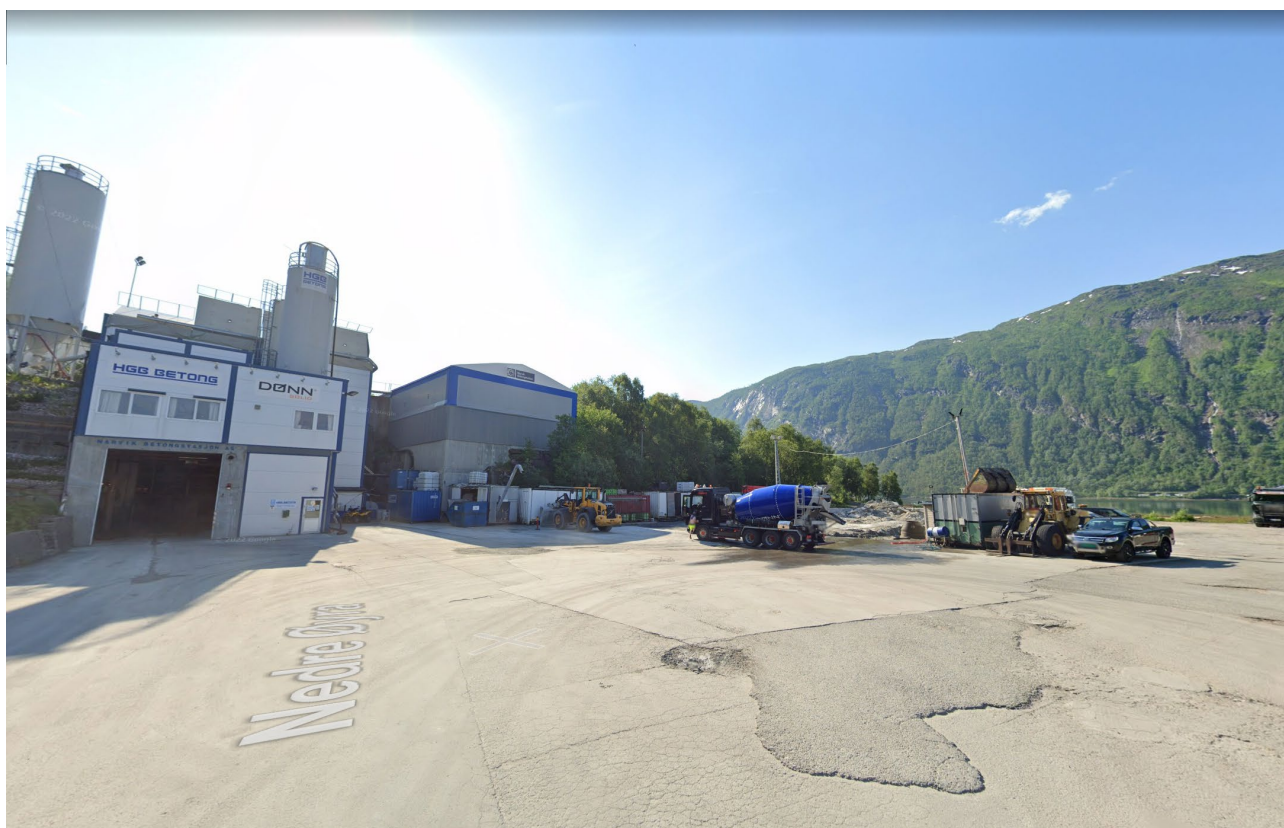
Figur 5 Dagens situasjon i området hvor det nye sedimentbassenget planlegges etablert (Foto: Google Street View).
