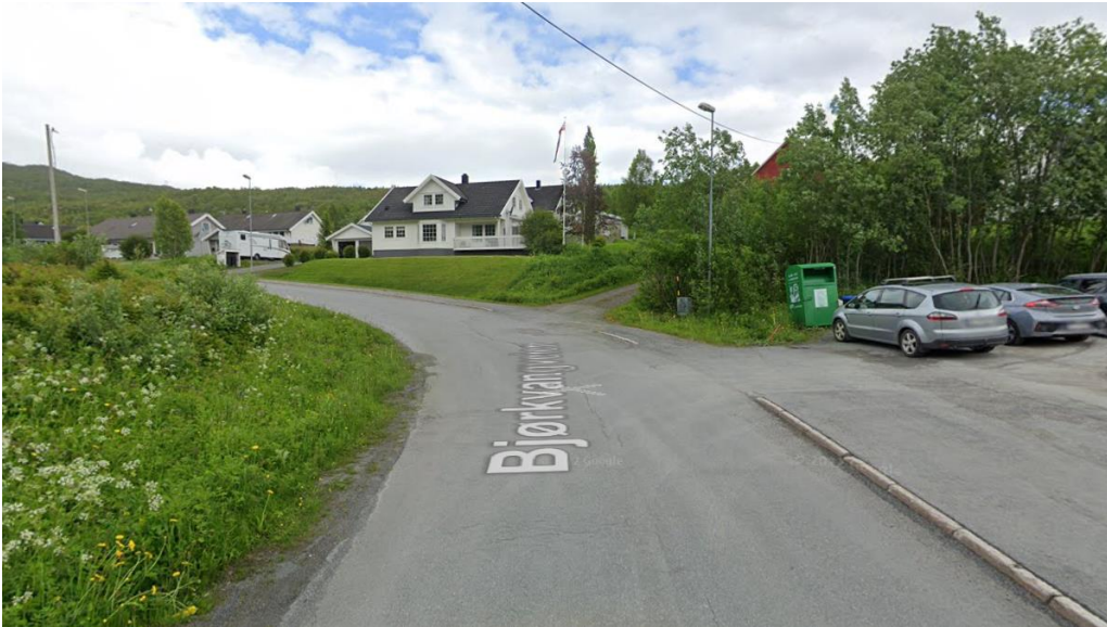
Figur 25: Gang- og sykkelveg langs Bjørkvangveien. Kilde: Google Maps.
