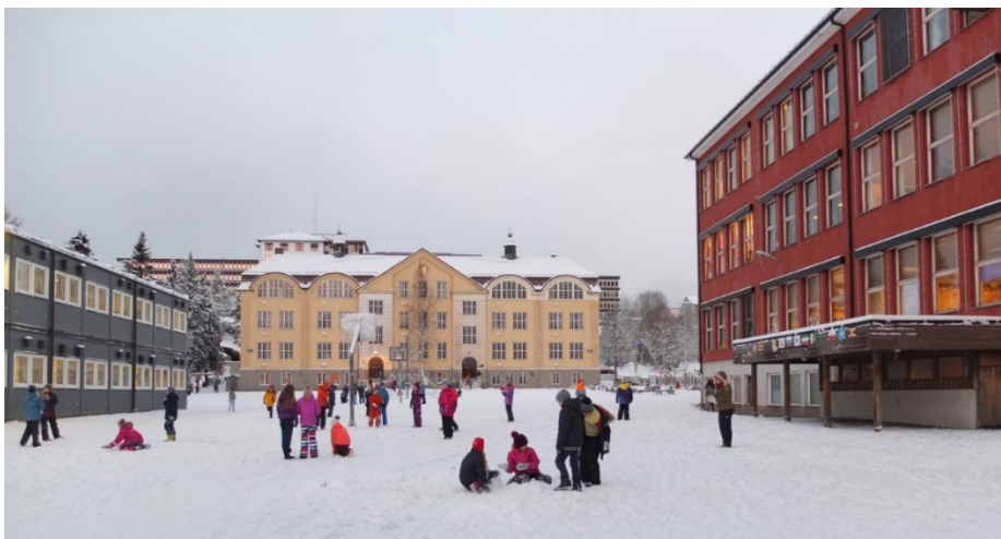
Figur 9. Brakker til venstre, Gulskolen i fonden og Rødskolen til høyre, sett fra syd. Foto Gisle Jakhelln nov. 2018.
