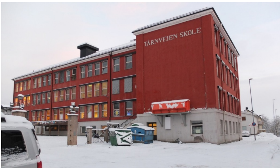
Figur 10. Rødskolen, sett fra SV, fra Tårnveien. Foto Gisle Jakhelln nov. 2018.
