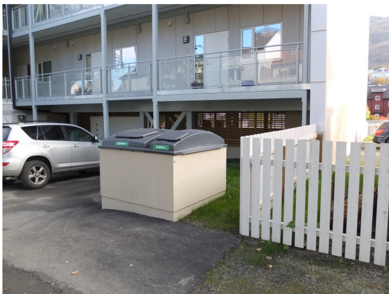
Fig. 23. Dypoppsamlingsanlegg, renovasjon, for Frydenlundsgata 31, mot intern servicevei. Foto Gisle Jakhelln sept. 2016.
